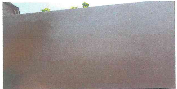
Foto 6: Levantado y tallado de muro en sector de area de cocina.
