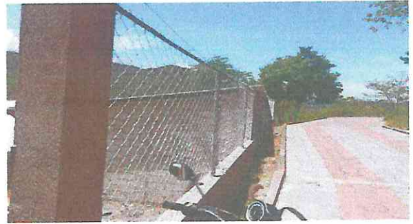
Foto 2: Imagen de muro ubicación este.
