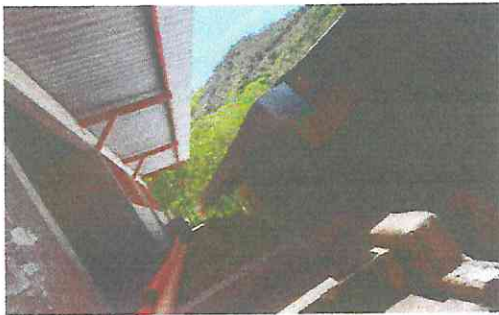
Foto 3: Imagen de canal tipo americano ara captacion de aguas pluviales
