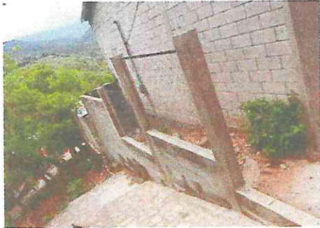
Foto 1: Imagen de muro ubicación oeste.
